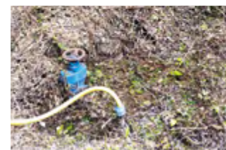
▲ Creusement du tuf pour l'entretien d'une vanne à Saint-Lattier (Isère). © IFREEMIS
