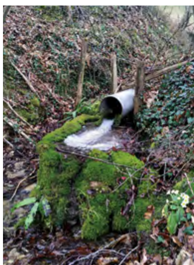
▲ Canalisation et dérivation d'un écoulement à la source à Saint-Nicolas-de-Macherin (Isère). © IFREEMIS
