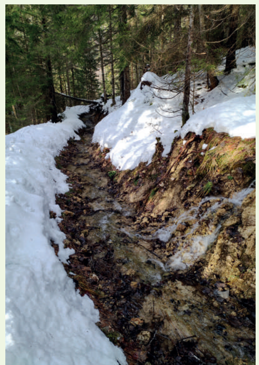
Écoulement chenalisé sur la tufière de la Touvière avant la phase de travaux ; © IFREEMIS
