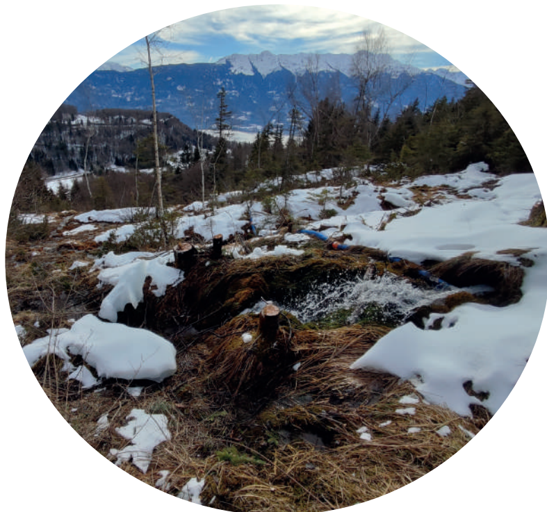
Réouverture du milieu et utilisation de tuyaux de type drains agricoles sur la tufière des sources du Bontey ; © IFREEMIS
